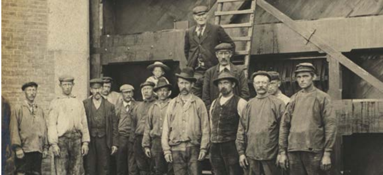
Figuur 16: werkzaamheden ten behoeve van de bouw van een tweede sluis in het Merwedekanaal te Utrecht: poserende arbeiders bij een sluisdeur, omstreeks 1904-1905. Bron: Het Utrechts Archief
