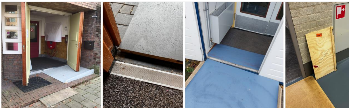
Figuur 2.7 Inadequate drempeloverbruggingen bij entree stemlokaal en -bureau bemoeilijken betreedbaarheid
