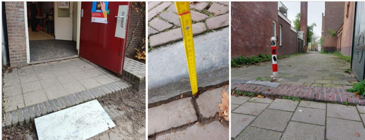
Figuur 2.5 Niet adequate of ontbrekende drempeloverbruggingen beperken bereikbaarheid
