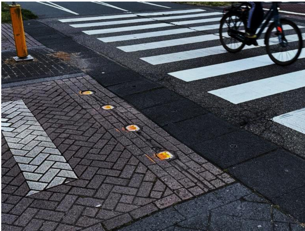
Figuur 4 De lampjes van de Zebra-Safe gaan aan wanneer er overstekende fietsers en/of voetgangers worden gedetecteerd door camera's bij de oversteek (2026)
