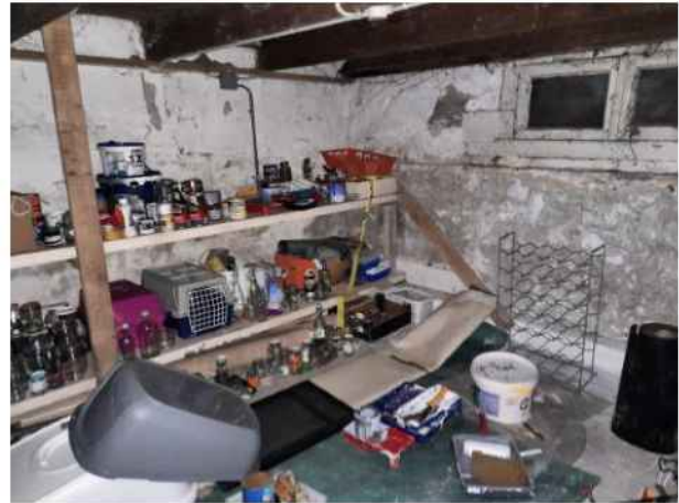
Kelder 1 (Visueel geen loden leidingen aangetroffen)
