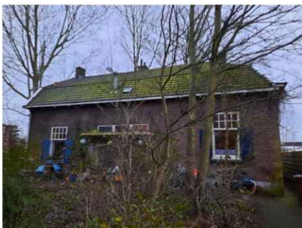
Overzicht zijkant woning (Visueel geen loden leidingen aangetroffen)
