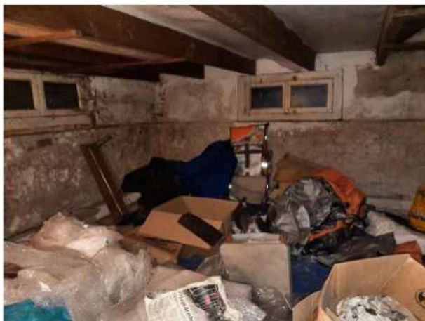
kelder 2 (Visueel geen loden leidingen aangetroffen)
