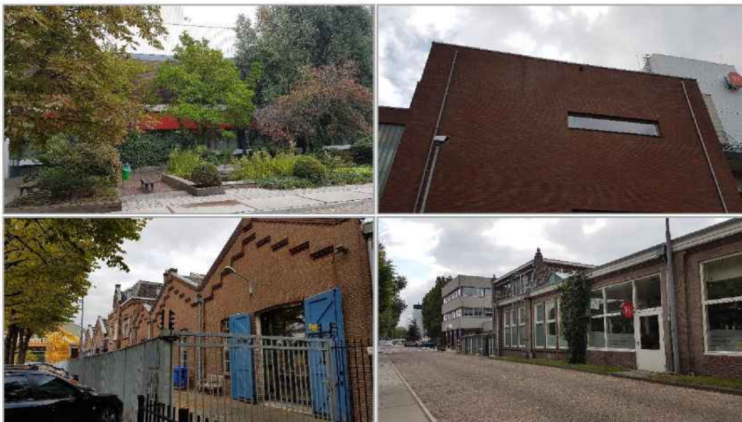
Figuur 5 Impressie van de gebouwen buiten de invloedsfeer van de werkzaamheden.
