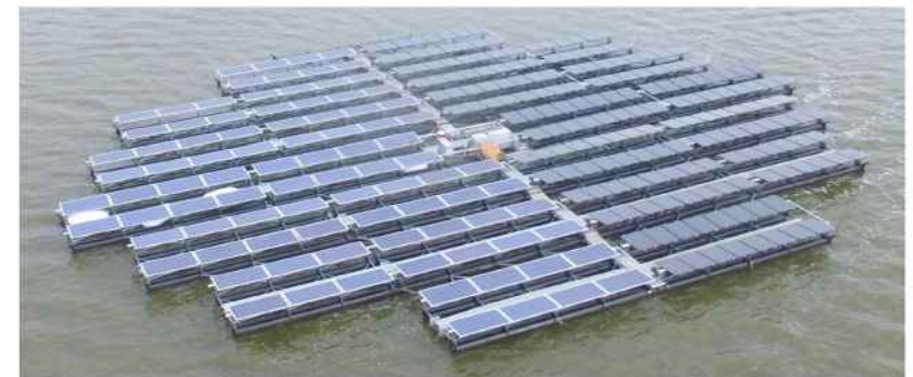
Afbeelding 7. Voorbeeld roterend drijvend zonne-energiesysteem.
