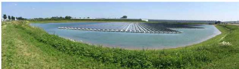
Afbeelding 9. Drijvend Zonnepark Lingewaard, bestaande uit 6.150 zonnepanelen (1,6 ha, circa 1,8 MWp) op een gietwaterbassin. Gerealiseerd in 2018 door Coöperatie Lingewaard Energie 19 .
