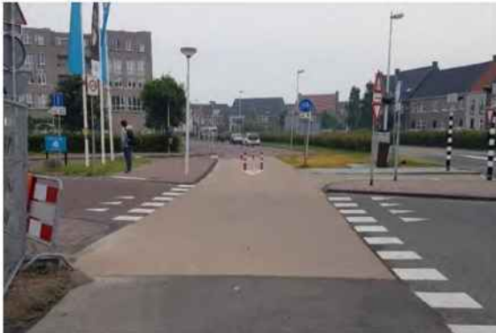
Foto 4 – ontbrekende markering op fietspad bij auto-oversteek.
