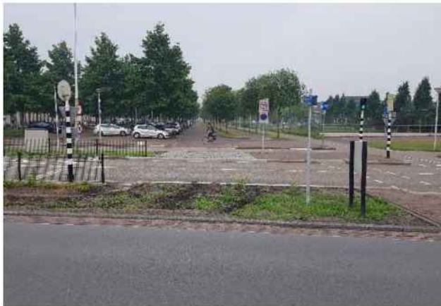
Foto 9 – Bandensporen in de berm langs de busbaan.
