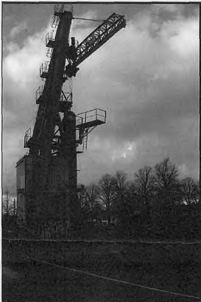
Foto's Elevator kraan Kanaalweg d.d. 20 november 2020
