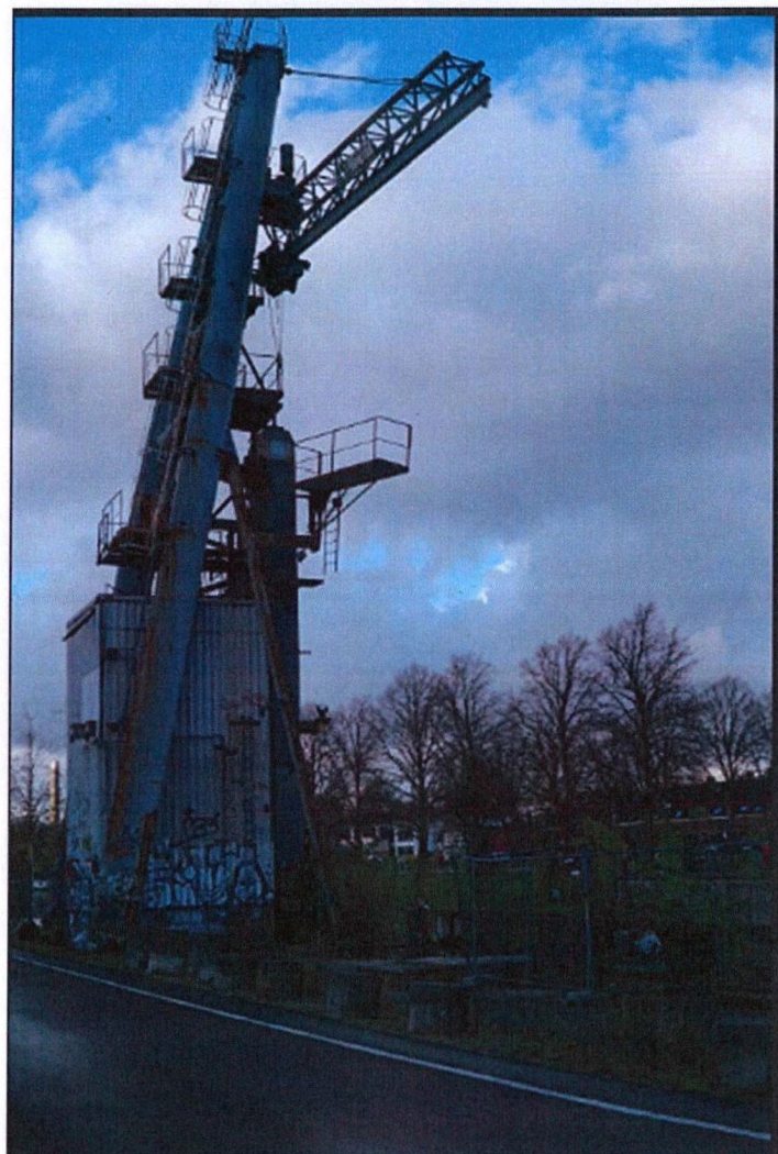
Foto's Elevator kraan Kanaalweg d.d. 20 november 2020
