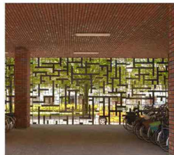
fietsenstalling met loopruimte aan de gevel
