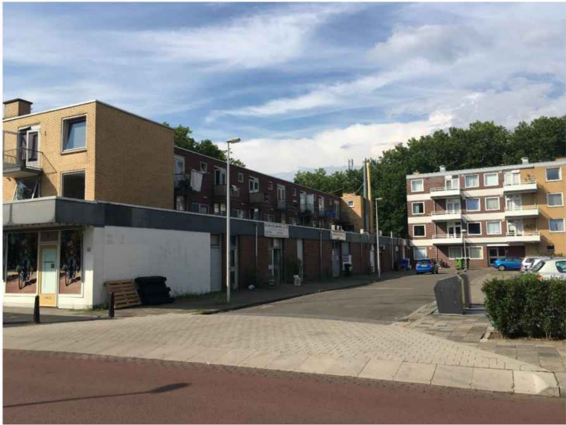
Foto bestaande situatie: achterkant met bevoorrading en parkeerterrein
