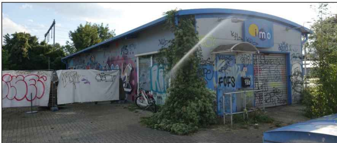
Figuur 2: De voorzijde en uitgang van de wasstraat. Het terrein is afgesloten met bouwhekken en verkeerd in een vervallen, overwoekerde staat.
