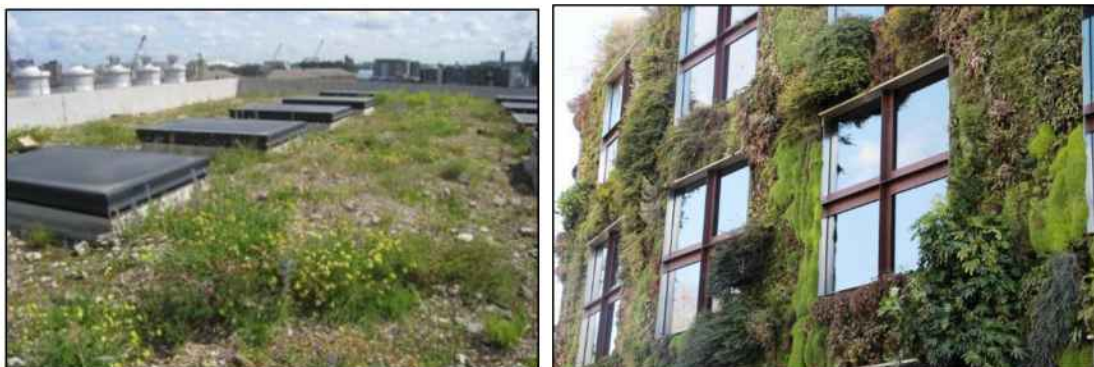
Figuur 15: Bruin dak (links bron: checklist groen bouwen) en groene gevel (rechts bron: groenkennisnet.nl).
