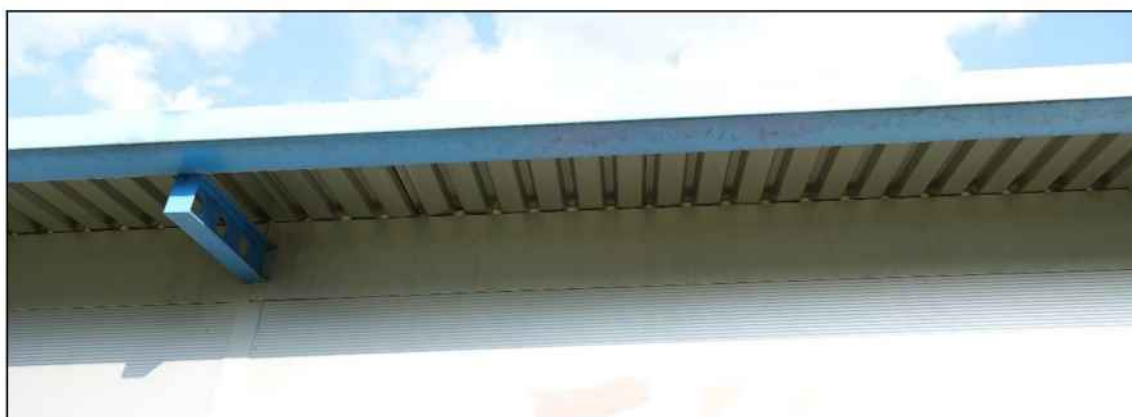
Figuur 10: Het gebouw van de wasstraat bestaat uit metalen wanden onder een dak van metalen platen en biedt geen ruimte aan vogels.
