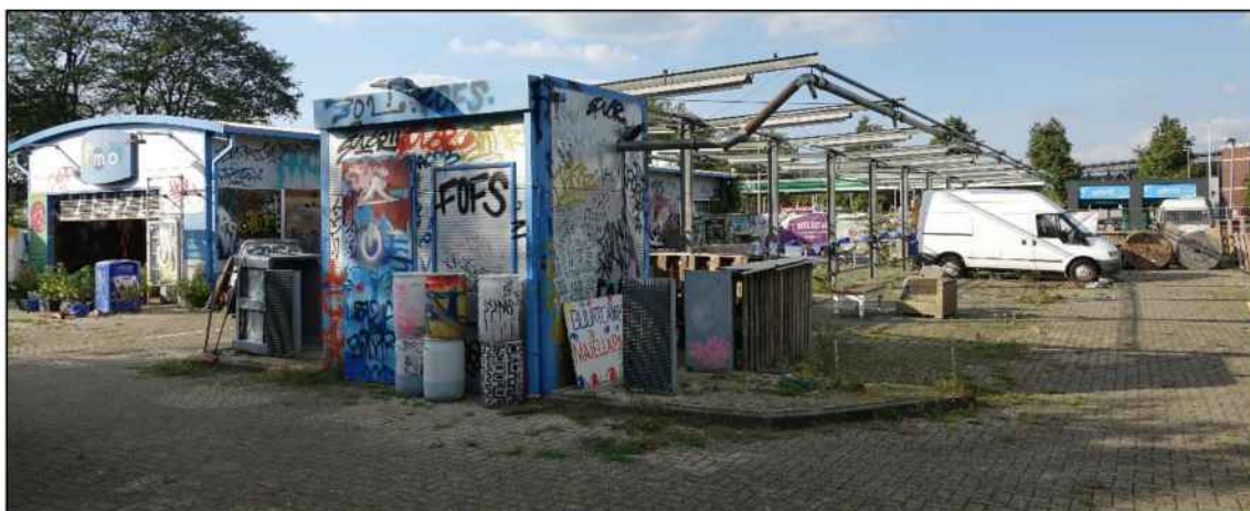
Figuur 3: De achterzijde en ingang van de wasstraat en de metalen "spoelcabines". Het terrein is grotendeels bestraat en op verticale oppervlakken is veel graffiti aanwezig.
