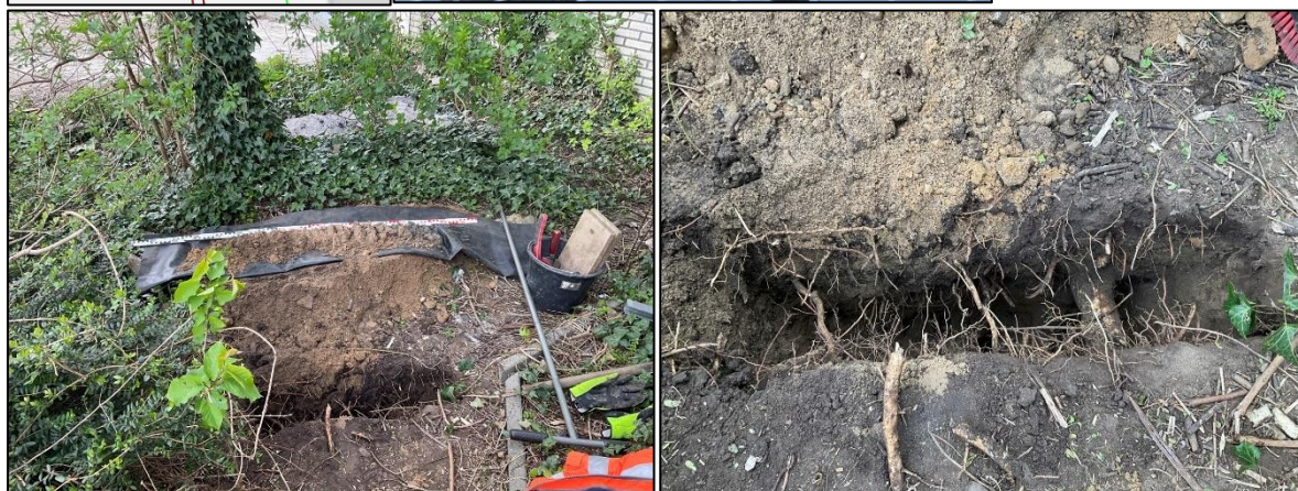
Foto 21: overzicht locatie 8 boom BTZ.0461. Sleuf gemaakt op rand verplantkluit. Boring is in de sleuf gemaakt.
