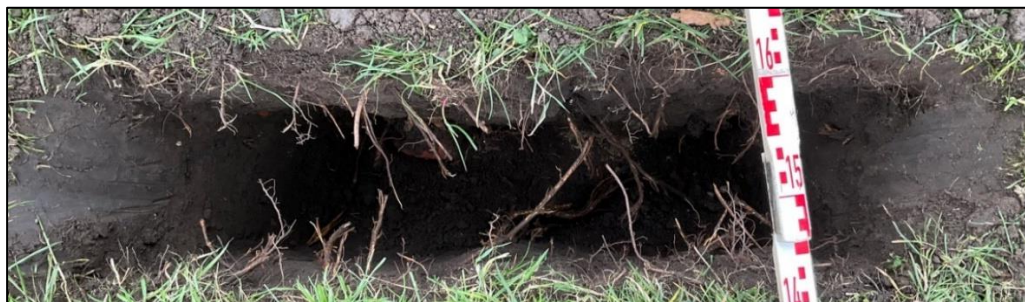
Foto 17: overzicht locatie 3. Sleuf gemaakt in de rand van de verplantkruit, ter hoogte van bundeling kabels en leidingen.
