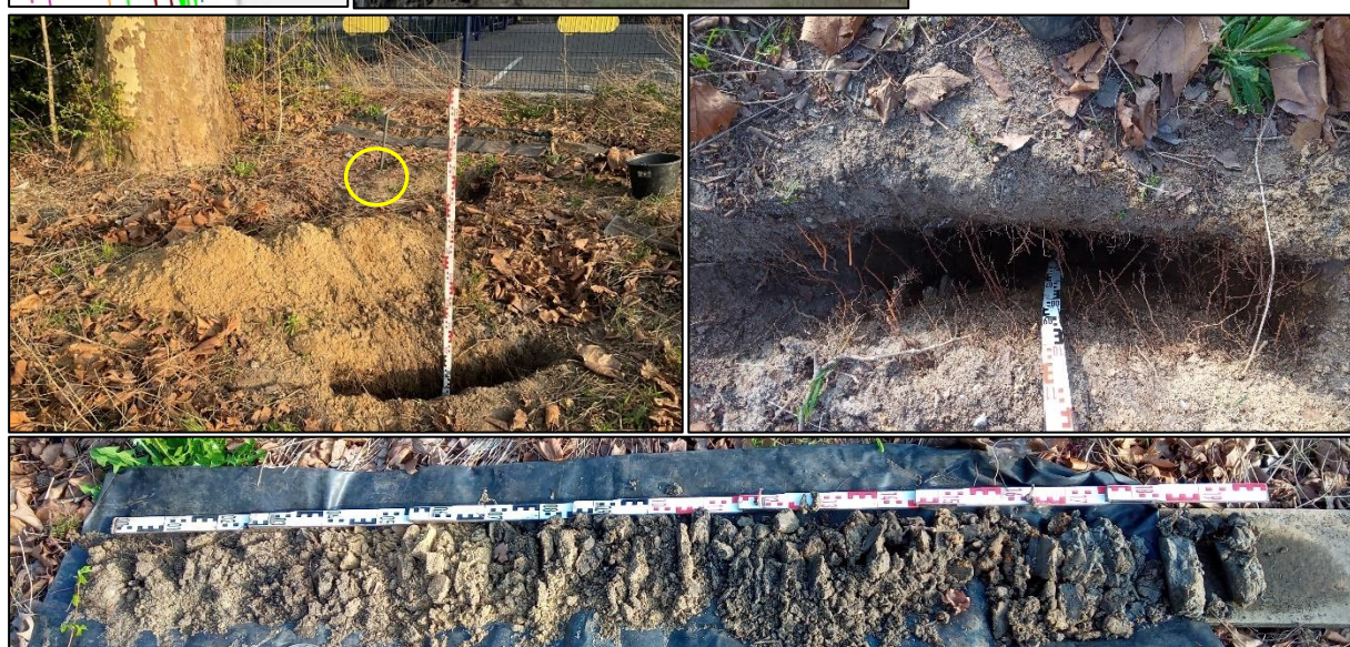
Foto 7: overzicht locatie 13. Sleuf gemaakt op rand verplantkruit. Boring is in de verplantkruit gemaakt (gele cirkel).
