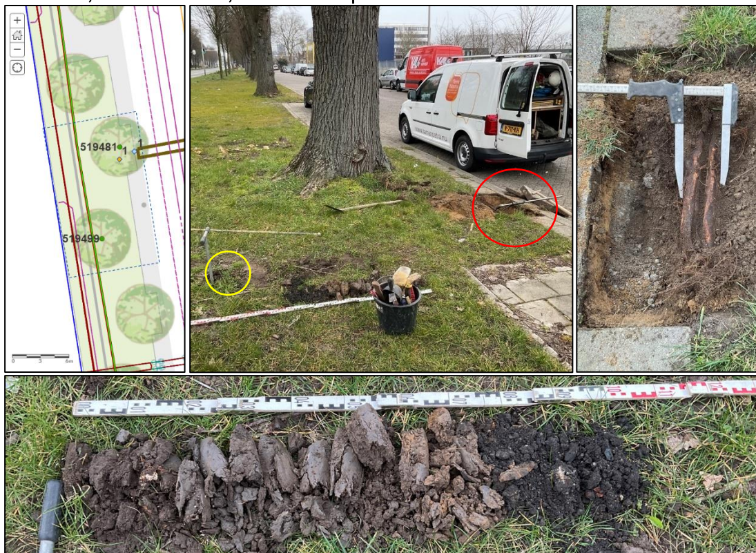
Foto 2: overzicht locatie 1. Boring (gele cirkel) en sleuf (rode cirkel) gemaakt in de beoogde verplantkult.
