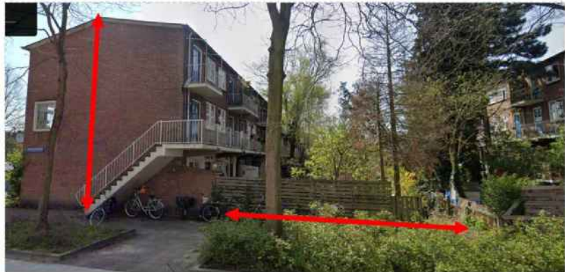
Figuur 2 Benodigde werkruimte voor sloop.
