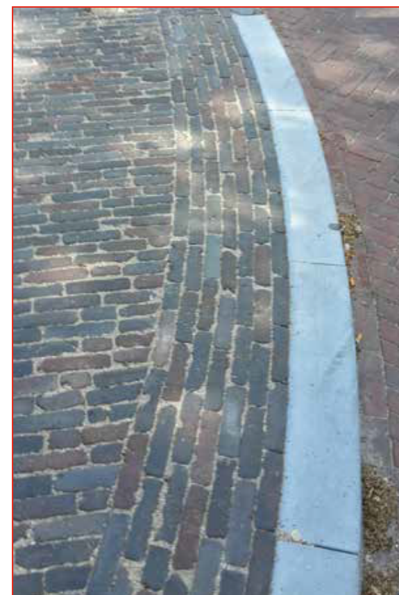
▲ Detail Hoek om keien sluit aan op trottoirband
