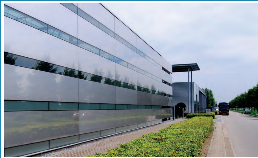
Horizontale geleiding gevel
