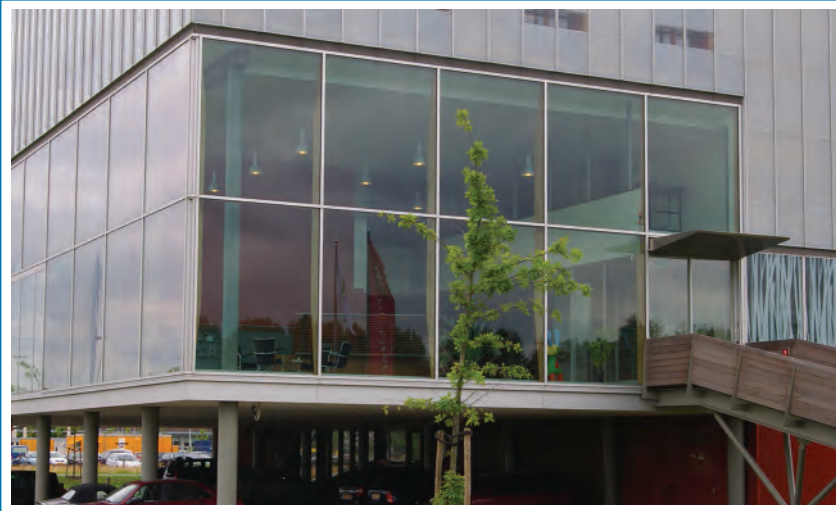
Glas in gevel
