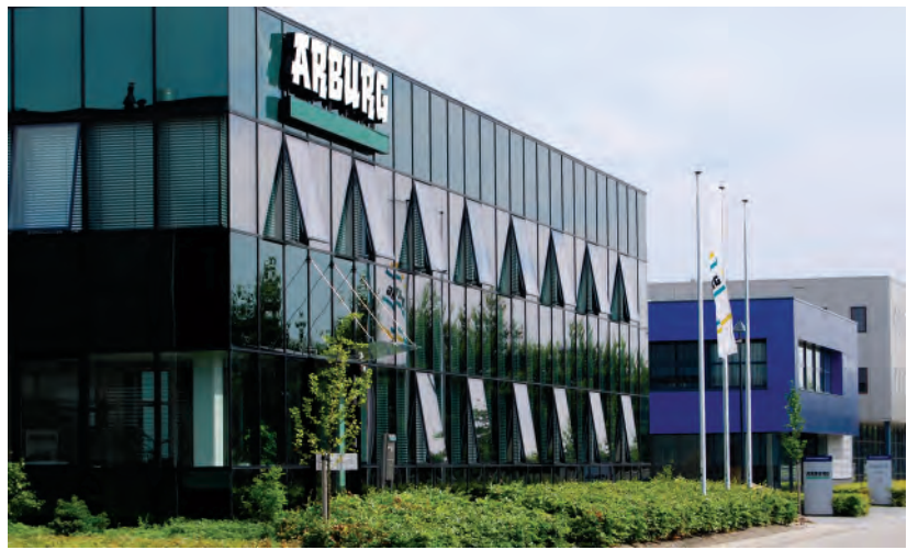
Uitgangspunt is het doorzetten van het beeld van De Wetering-noord
