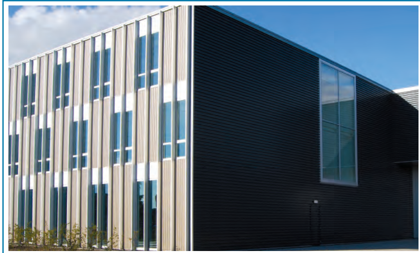
Glas in gevel
