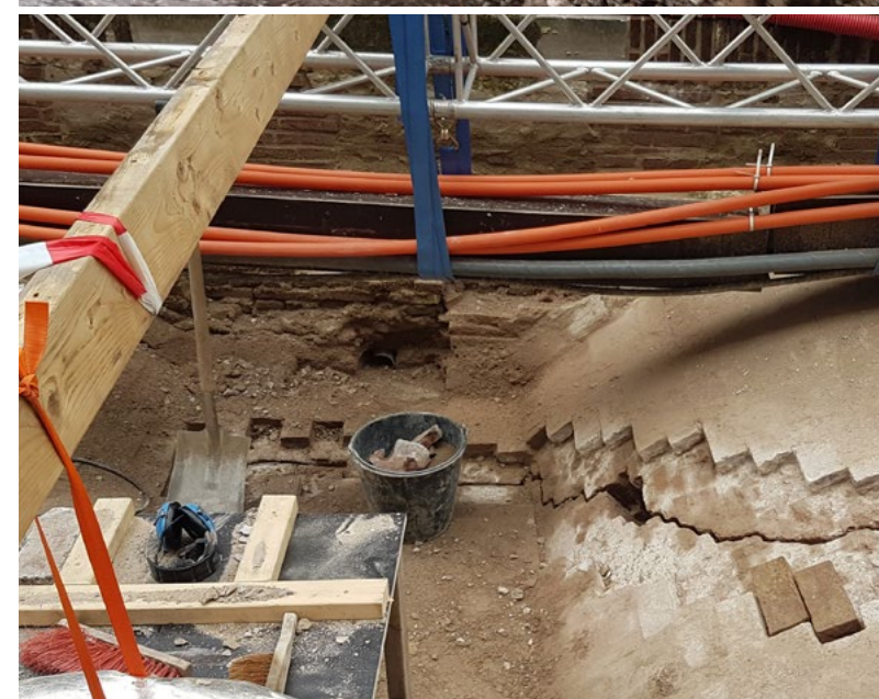
Boven: Een kelder met sporen van lekkages en vochtinwerking Onder: Herstel van grote scheuren aan de bovenkant van een keldergewelf (Foto's: gemeente Utrecht)
