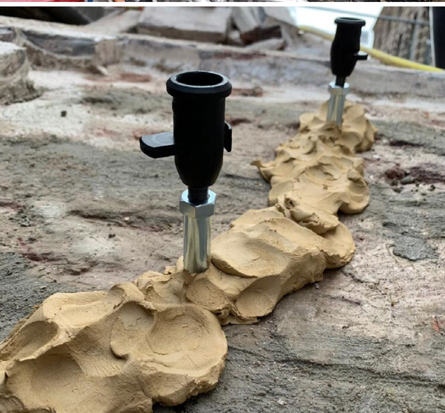
Boven: het aanbrengen van een waterdichte laag op een kelderboog Onder: het herstellen van scheuren in het metselwerk van de kelderboog (foto's: Gemeente Utrecht)
