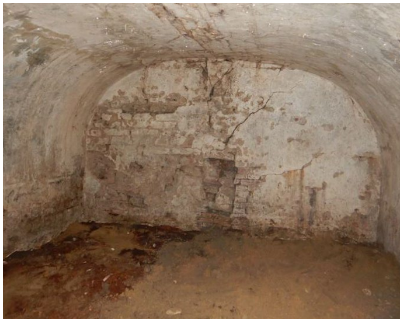
Boven: (schade door) boomgroei en worteldruk (foto: Frank Doves) Onder: schade aan een straatkelder aan de Hoogt (foto: M. van der Korput)
