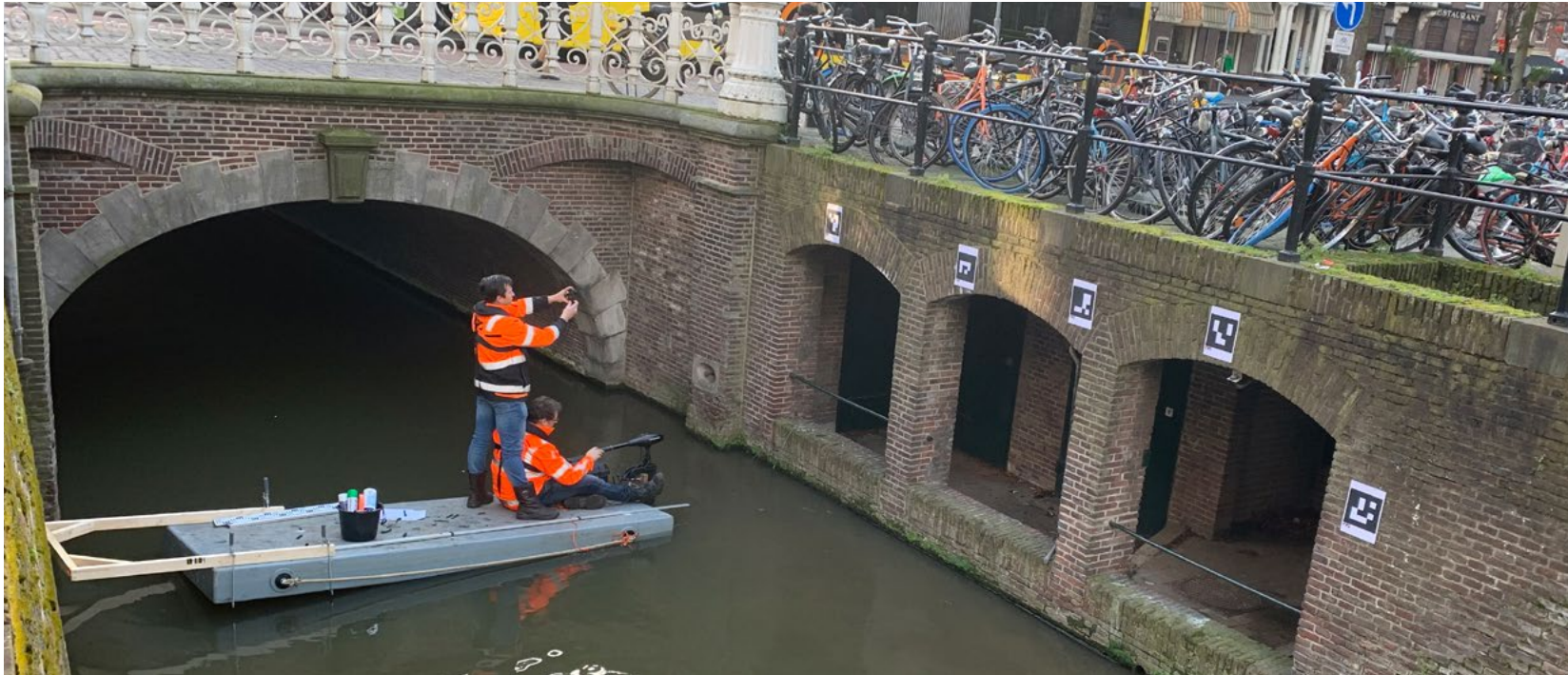
Links: inspectie van de kademuren op de Drift. Rechts: onderzoek aan de beschadigde fundering van walmuren (foto's: Gemeente Utrecht)
