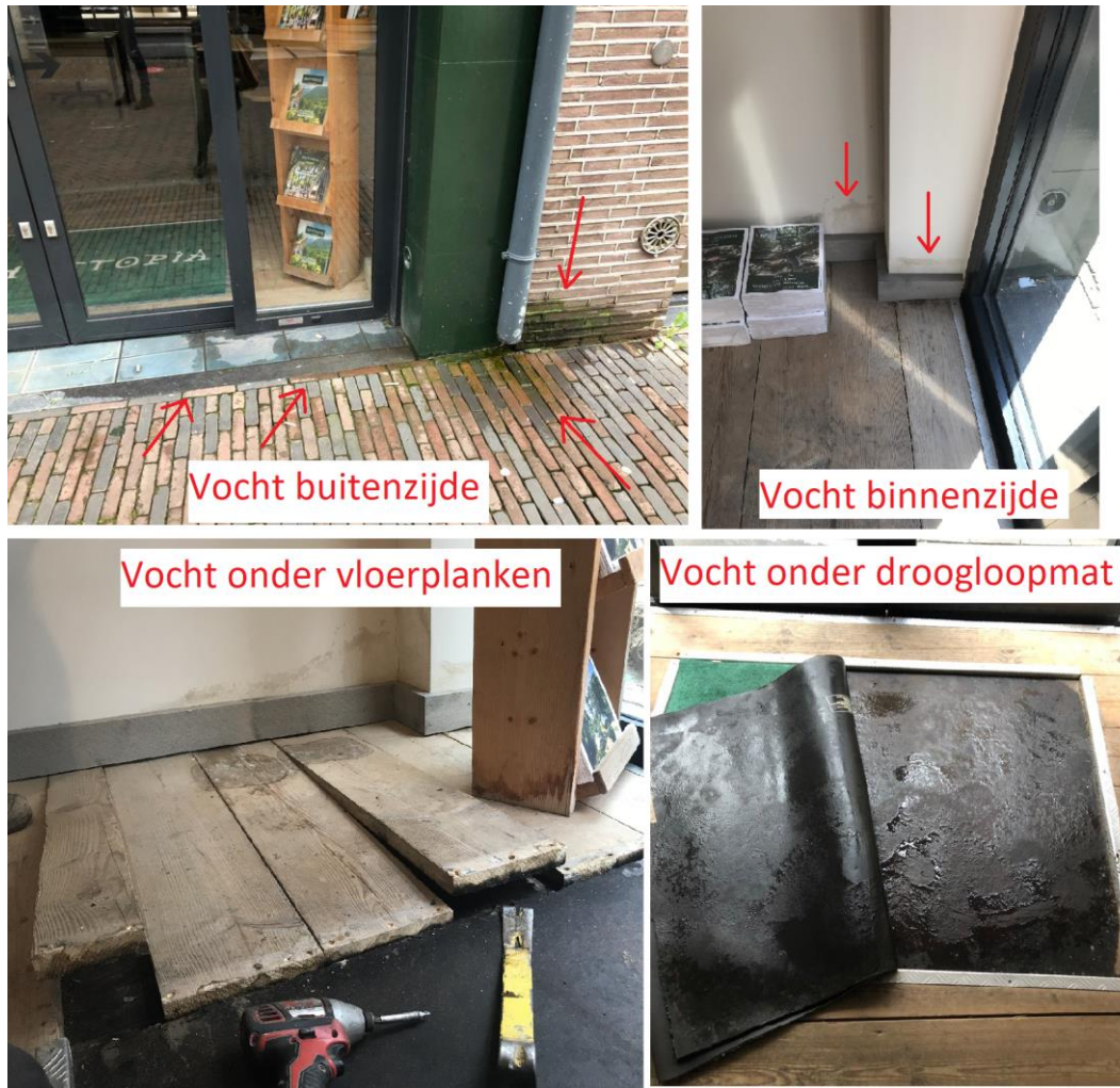
Afbeelding 2.4 Vocht in de zuidwesthoek, onder de vloerplanken en de droogloopmat
