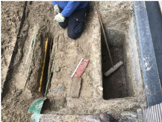
Afbeelding 3.7 Ontgraving boven zwik van kelderbogen nummer ■ en ■
