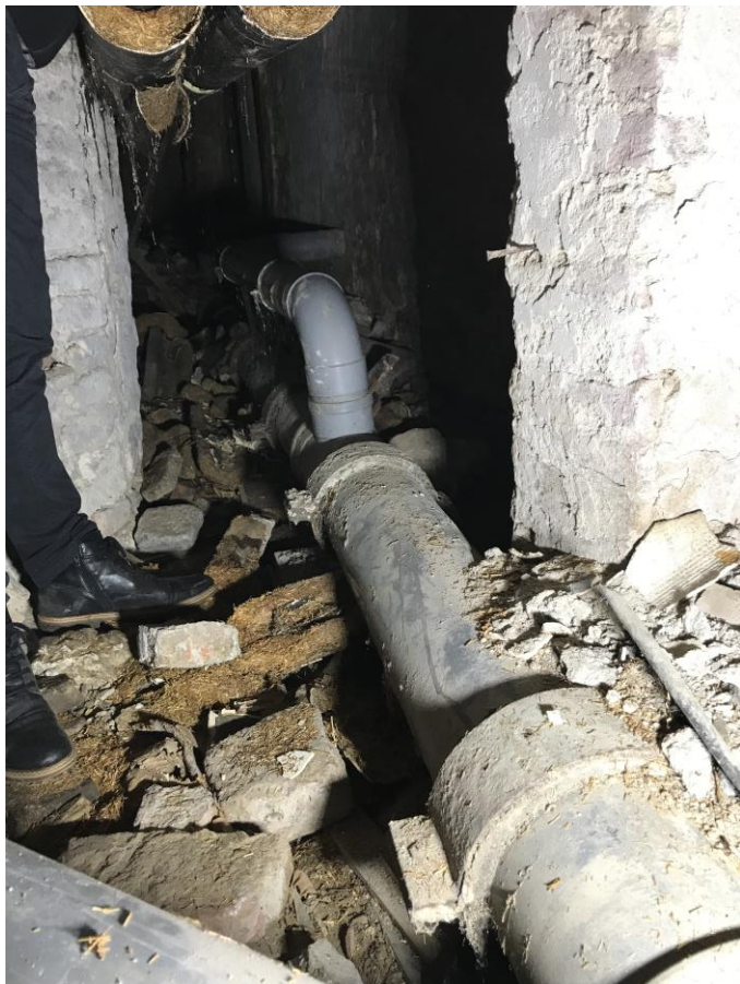
Afbeelding 2.3 ø200 mm rioolbuis in kelders, tevens weergegeven in afbeelding 2.1
