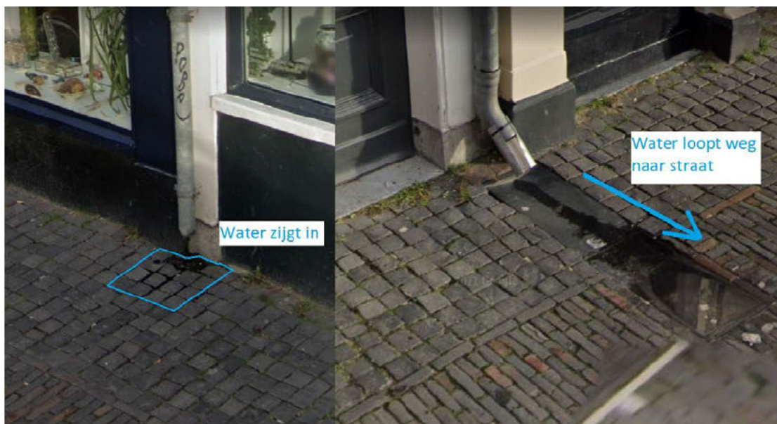
Afbeelding 5.1 Aanpassen dakafvoer nummer [REDACTED] (links) zoals nummer [REDACTED] (rechts)
