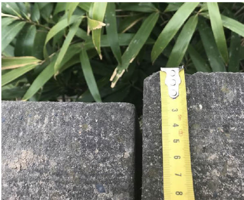
Afbeelding 4.11 Wijking frontmuur nummer [REDACTED] bij dilatatievoeg naast lantaarnpaal
