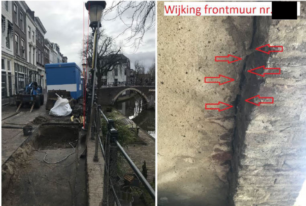
Afbeelding 4.10 Overhellende lantaarnpaal en wijking frontmuur bij nummer [REDACTED]
