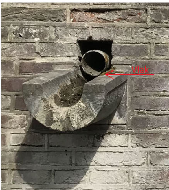
Afbeelding 4.7 Horizontale uitlaat van buis (links) en neerwaartse elleboog (rechts)
