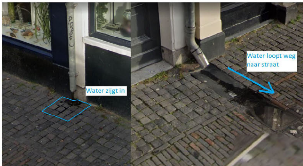
Afbeelding 3.11 Screenshots dakafvoer nummer [REDACTED] (links) versus dakafvoer nummer [REDACTED] (rechts) (bron: GoogleMaps)
