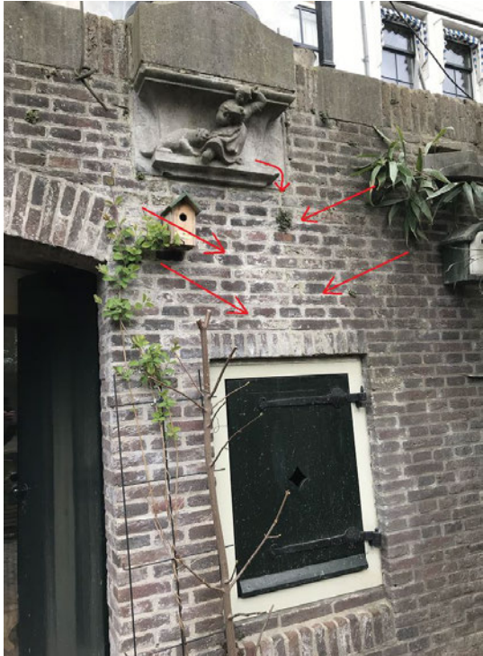
Afbeelding 4.8 Concentratie van water onder lantaarnpaal boven raam nummer ■■■
