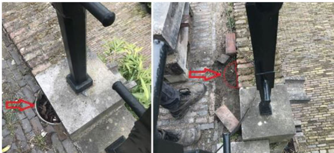
Afbeelding 3.5 Geblokkeerde molgootspuwers
