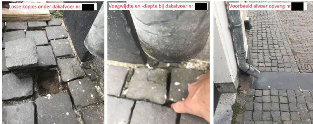
Afbeelding 3.10 Dakafvoer nummer [REDACTED] (links en midden) versus dakafvoer nummer [REDACTED] (rechts)
