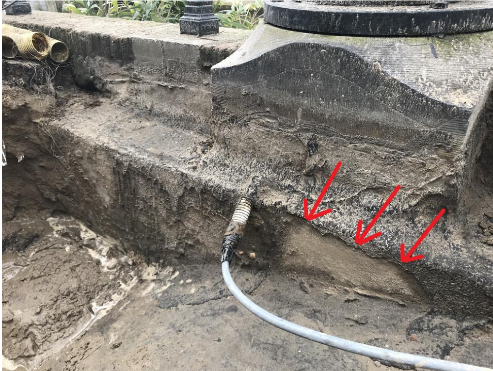
Afbeelding 3.12 Onthechte waterdichte laag bij voorkant L-muur. Tegenover nummer [REDACTED]
