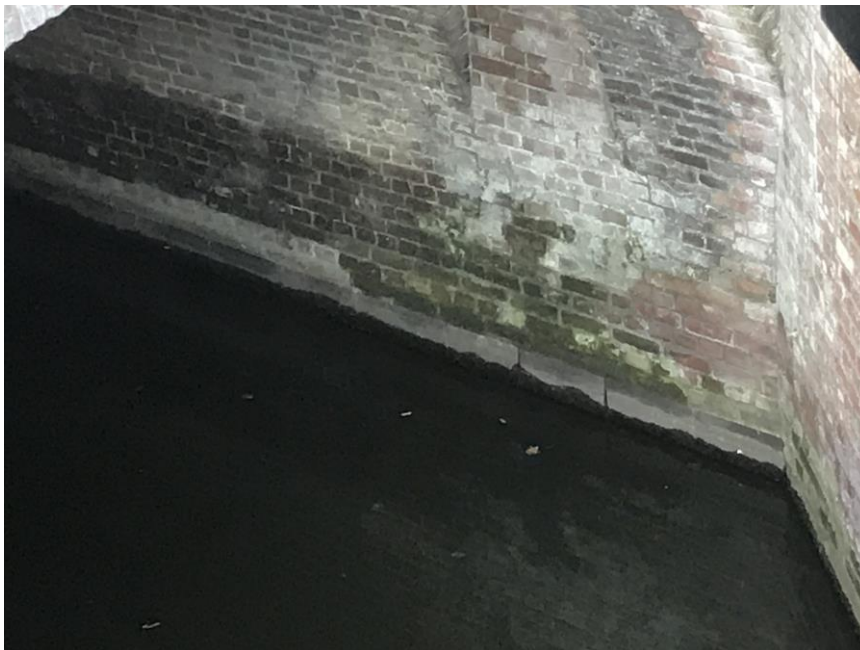
Afbeelding 4.2 Voorbeeld foto die inzuigende werking van oude baksteentypes toont
