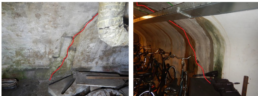
Figuur 3-11: voorbeelden van scheurtype V. [PTG14+16-ALG-011 en TWS2-SCH-002-002]
