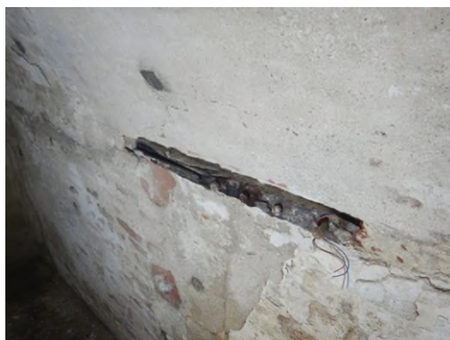
Figuur 3-13: voorbeelden van falende verankering [DRI23-SCH-002-002 en DRI21A-SCH-003-001]
