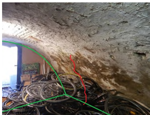
Figuur 3-7: Voorbeelden van Scheurtype III [DRI31-ALG-001 en OGR274-ALG-008]
