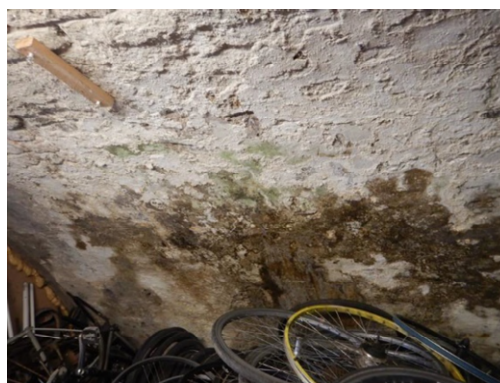
Figuur 3-14: voorbeelden van vochtschade: links schimmelvorming met kalkuitbloei [LNM19-ALG-005] en rechts schimmelvorming [OGR274-SCH-003-002]
