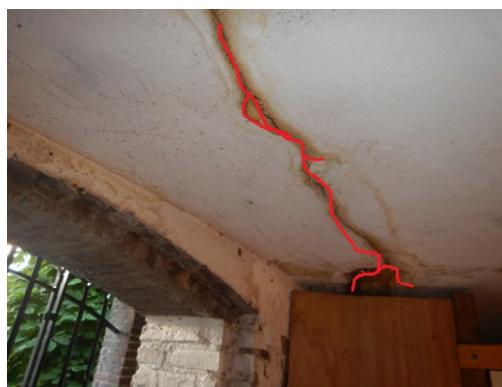
Figuur 3-5: Voorbeelden van Scheurtype II [LNM19-ALG-002 en TWS2-ALG-009]
