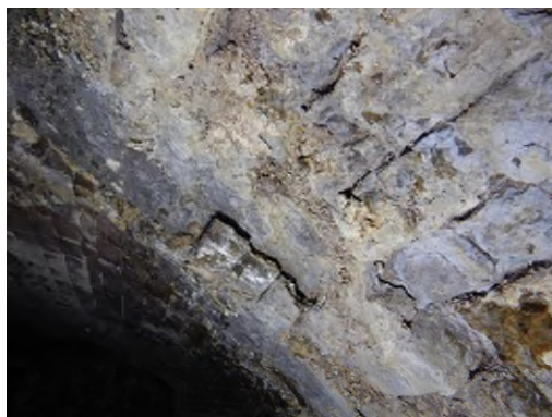
Figuur 3-12: lokaal losraken van stenen door slechte staat voegwerk [CHS20-SCH-001-002 en OGR274-SCH-002-002]
