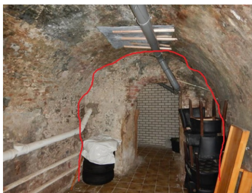
Figuur 3-5: Voorbeelden van Scheurtype II [LNM19-ALG-002 en TWS2-ALG-009]
