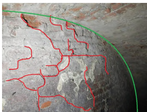
Figuur 3-3: Voorbeelden van scheurtype I [PTG13-ALG-008 en ZDS23-SCH-001-002]
