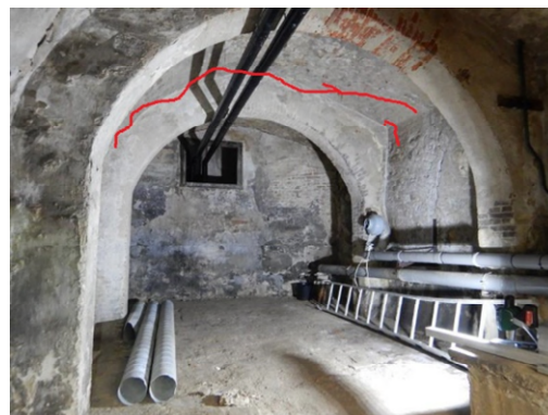
Figuur 3-9: voorbeelden van scheurtype IV. Links scheur t.p.v. kolom [OGR381-ALG-007 CHS10+12-SCH-001-002]
