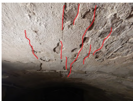
Figuur 3-3: Voorbeelden van scheurtype I [PTG13-ALG-008 en ZDS23-SCH-001-002]
