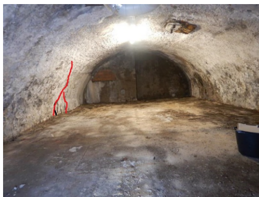
Figuur 3-7: Voorbeelden van Scheurtype III [DRI31-ALG-001 en OGR274-ALG-008]
