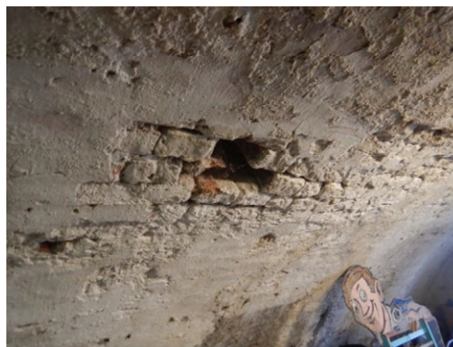
Figuur 3-12: lokaal losraken van stenen door slechte staat voegwerk [CHS20-SCH-001-002 en OGR274-SCH-002-002]
