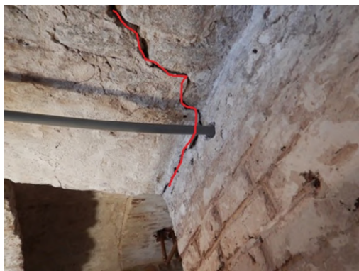
Figuur 3-9: voorbeelden van scheurtype IV. Links scheur t.p.v. kolom [OGR381-ALG-007 CHS10+12-SCH-001-002]
