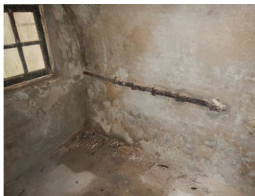
Figuur 3-13: voorbeelden van falende verankering [DRI23-SCH-002-002 en DRI21A-SCH-003-001]
