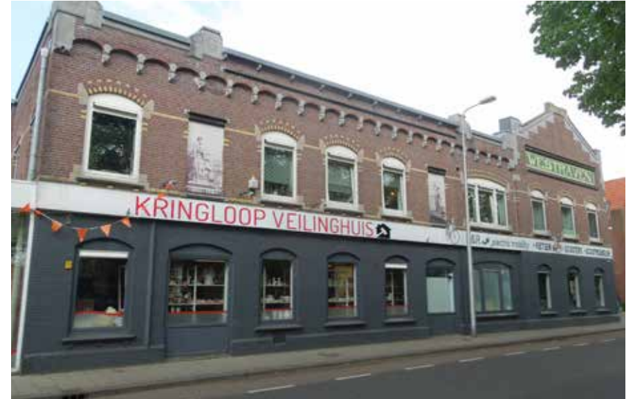
Recente foto van de voormalige tegelfabriek. Bron: Bouwhistorische verkenning voormalige tegelfabriek 'Westraven', Jutfaseweg 178-181 te Utrecht, Bureau Helsdingen 28 juli 2020
