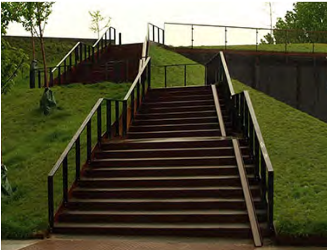
referentie steil talud met trap
