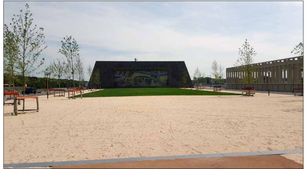
Dienstengebouw A2-tunnel, vanaf Berlinplein
