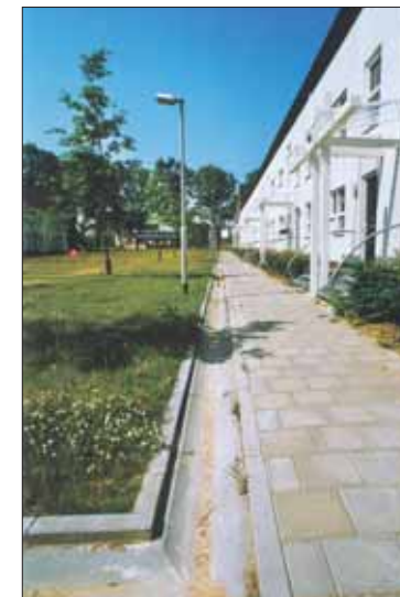
Goten tbv dakwater
