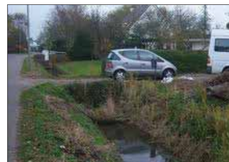
Dam met duiker over hoogwatersloot
