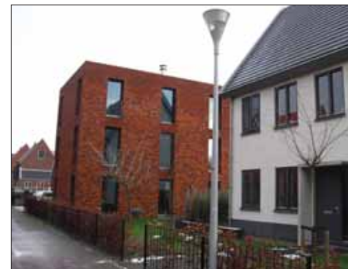
Afwijking in kleur, materiaal én kapvorm
