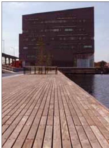
Houten vlonder als verblijfsplek / aanlegplaats
