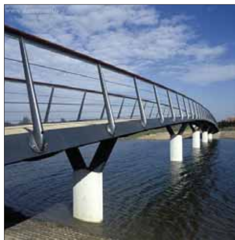
Brug met tussensteunpunten
