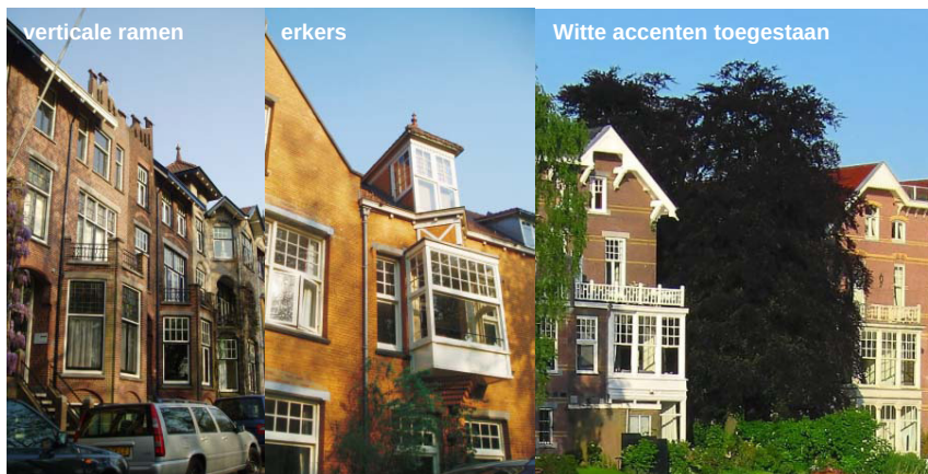
Woningen park- en zuidzijde: gevel dominanten dan het dak.
