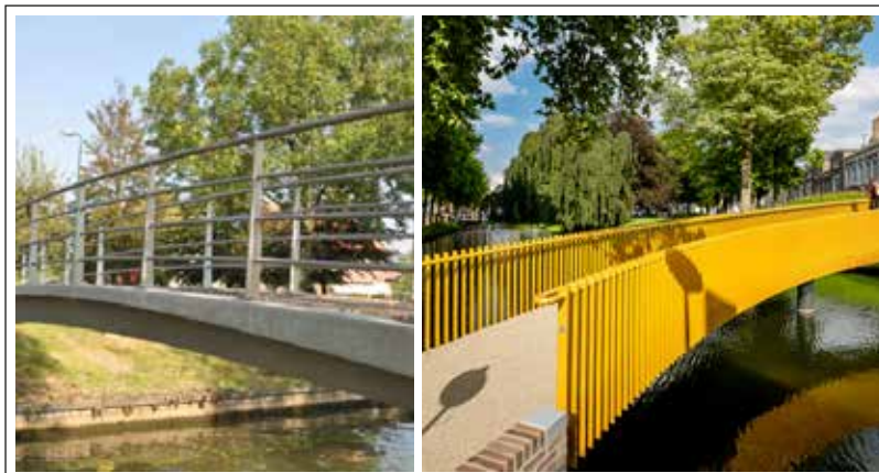
Referentiebeelden materiaal en detaillering van Sijpesteijnbrug
