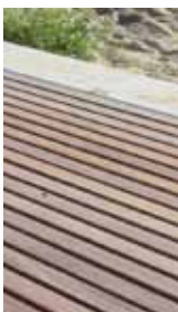
Houten dek, gecombineerd met beton
