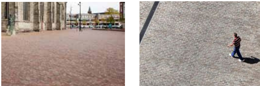
Speciaal materiaal binnen de pleinen (stelconplaten)
