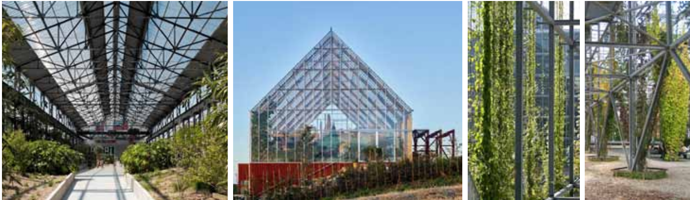
voorbeeld van toepassing oude spanten en kolommen ten behoeve van een kas bij Villa Jongerius
