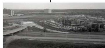
1978: Aanleg knooppunt Rijsweerd
