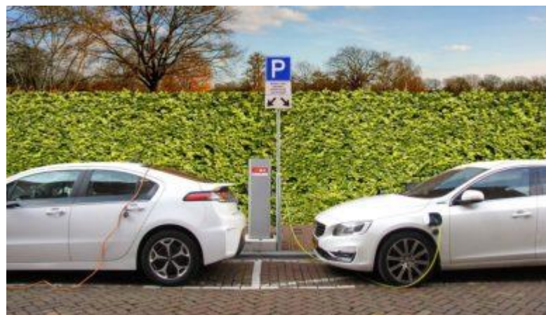
Figuur 1: Publieke laadpaal met netaansluiting
