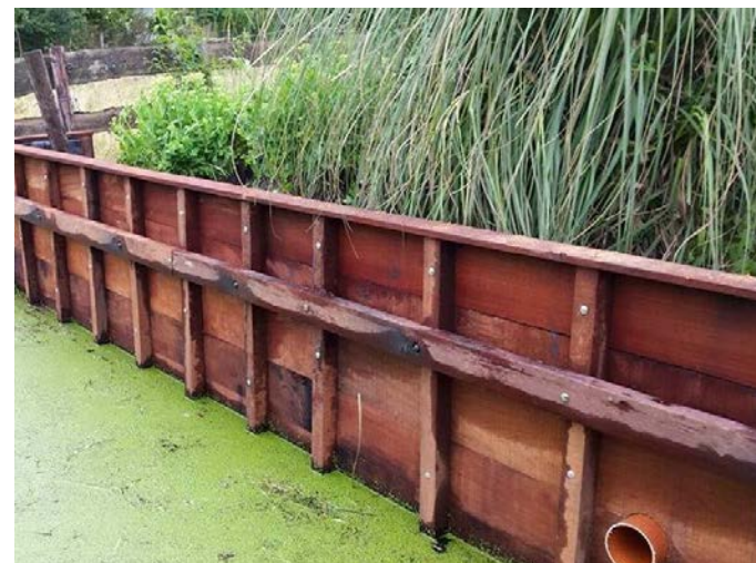
Lozingspunt van een ondergrondse afvoer op de watergang
