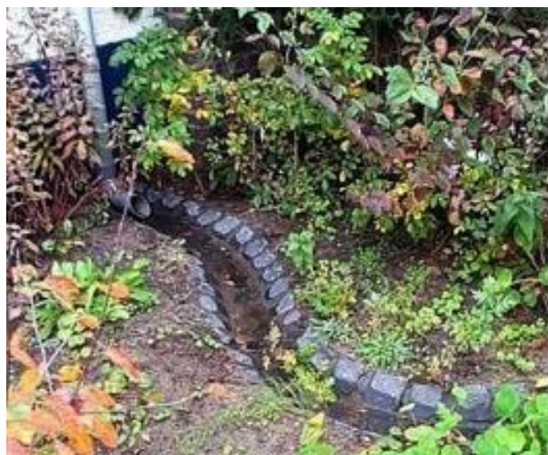
Regenwater via een bovengrondse goot
