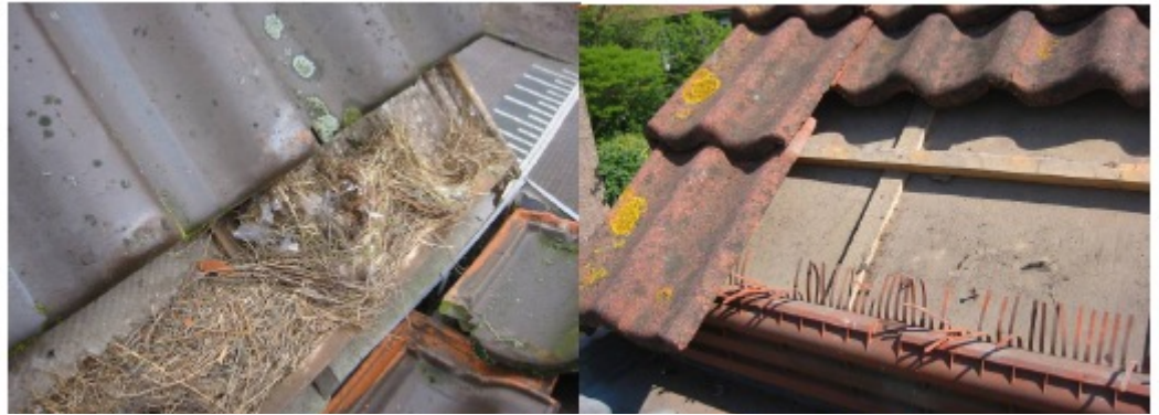
Figuur 18: Vogelschroot verhindert de toegang tot nestgelegenheid onder de onderste rij dakpannen (bron: Foto's: Hans Borra / comfortdak).
