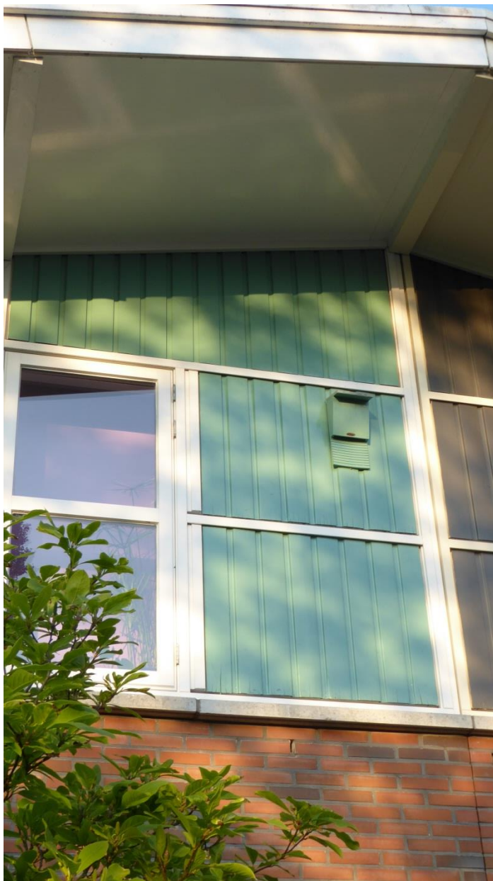
Vleermuiskast aan woonhuis.
