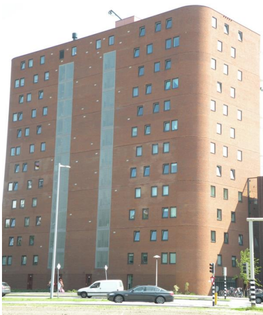
Ingemetselde gierzwaluwkasten bij nieuwbouw aan de Talmalaan.
