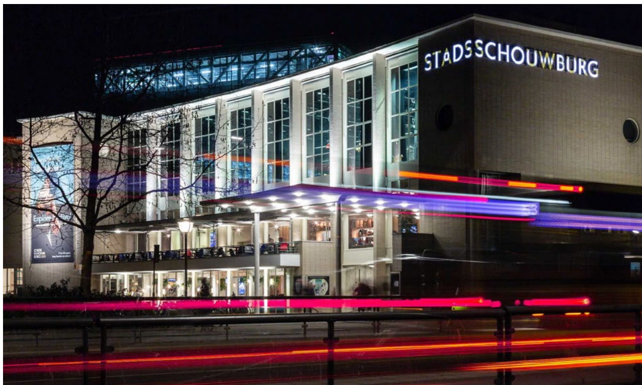
De Stadsschouwburg Utrecht op het Lucasbolwerk, een belangrijke stedelijke publieksvoorziening in vastgoed van de Gemeente Utrecht © Dorien Hein
